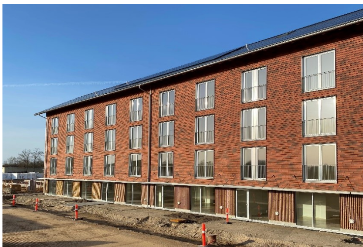
Taastrupgaard EFTER renovering
