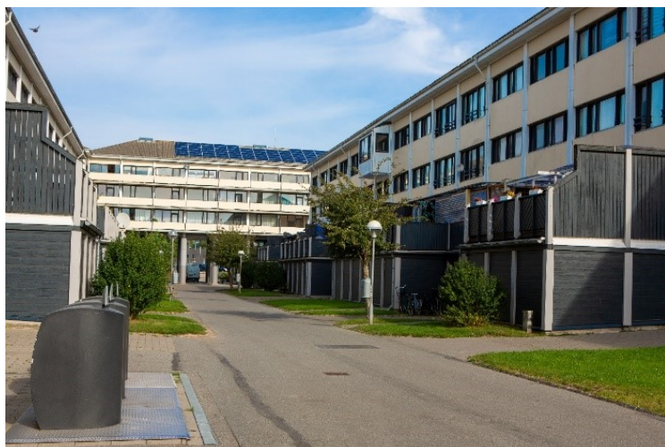
Taastrupgaard FØR renovering
